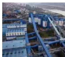
陕西榆林大流塔 煤矿工业园区
